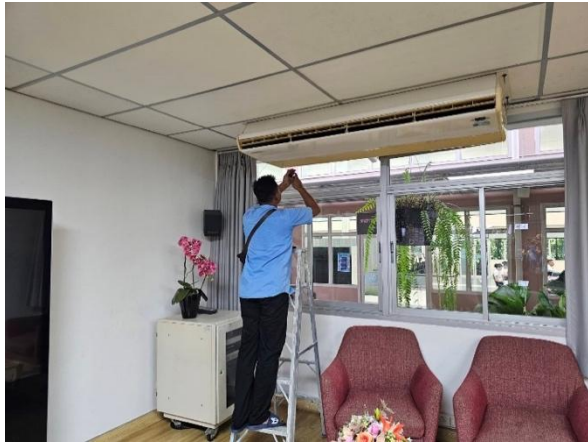
ก่อนการดำเนินงาน
