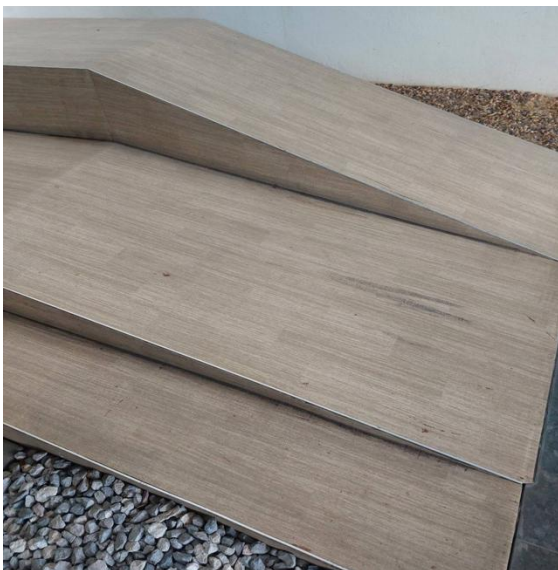
ก่อนการดำเนินงาน
